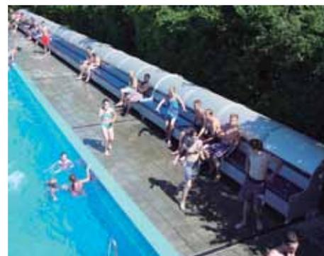
*Cubierta desplazable sobre guías.*
